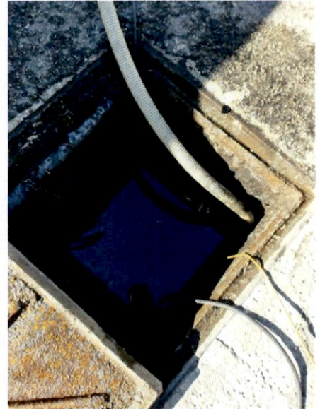
svuotamento pozzetto con pompa eco
