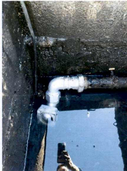
montaggio pompa e collaudo
