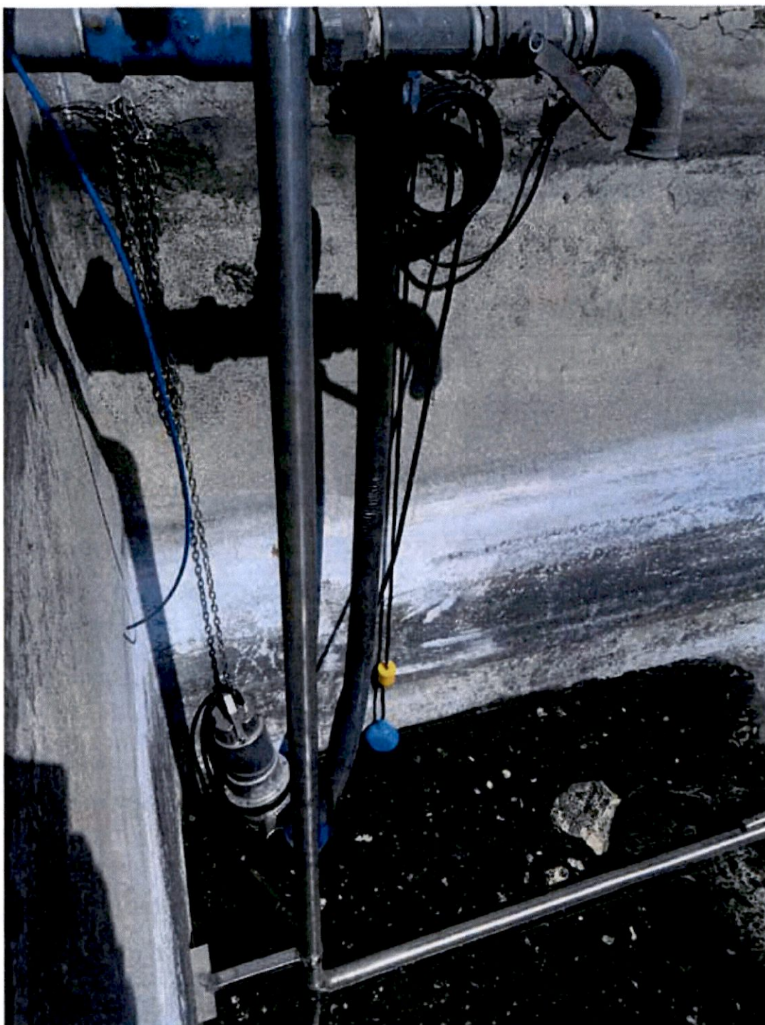
Sostituzione Elettropompa di mandata alla Chiariflocculazione
